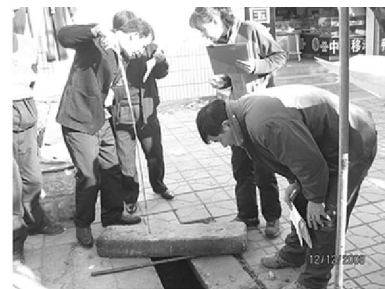
图 3 地下管线探测成果现场开井检查
