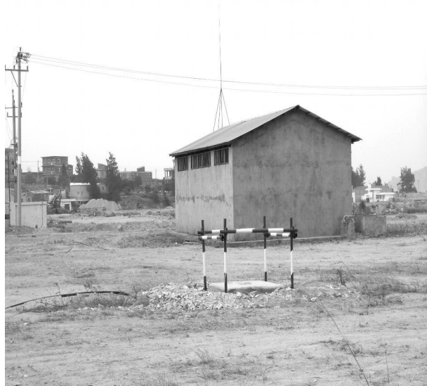
图1 钢管防护设施
